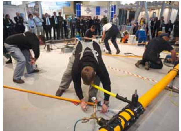
Zum ersten Mal konnten Besucher der gat beim „DVGW-Pipetapping“ Baustellen- und Wettkampfatmosphäre inmitten der Fachausstellung erleben. Teams aus Auszubildenden des Gas- und Wasserfaches und erfahrene Monteure von DVGW-Mitgliedsunternehmen traten gegeneinander an, um ihr Fachkönnen und ihre Erfahrung bei Rohrleitungsbauarbeiten zu präsentieren. Sieger wurde das Team der Stadtwerke Lübeck Netz GmbH.
